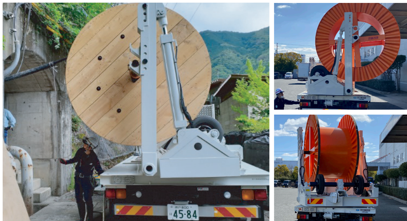
ターンテーブルを180°回転しながらのケーブル布設作業中。 様々なドラム種類にも対応しております。
